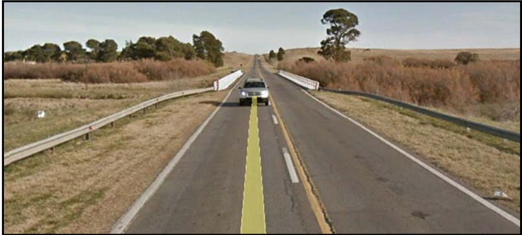
**Foto 1 Aproximación al puente sobre el A° de Las Mostazas. Estrechamiento del coronamiento**
