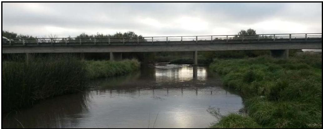
**Foto 2 Vista del puente sobre el A° de Las Mostazas: 6 luces de 15 m**
